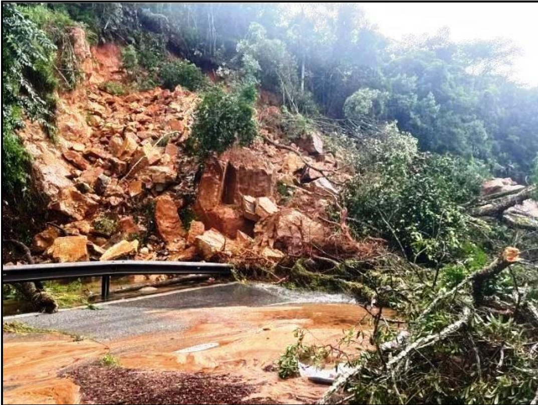
Deslizamento na pista Morro dos Macacos na Grande Florianópolis. Foto Notiserra SC.
