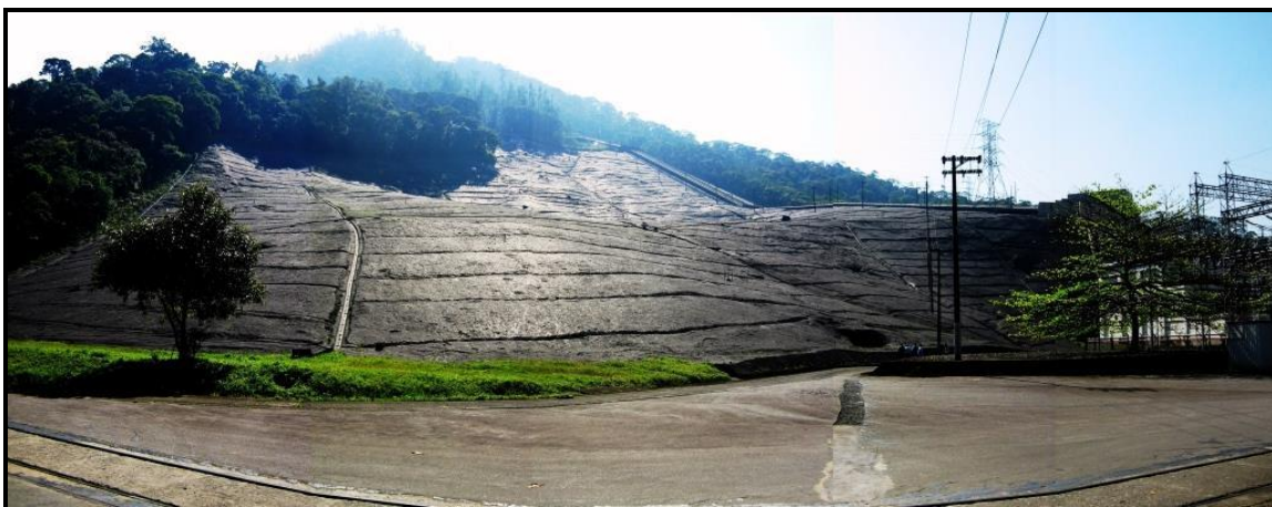
O grande corpo de tálus cuja movimentação ameaçou seriamente as instalações da Usina Elétrica Henry Borden foi trabalhosamente estabilizado via impermeabilização superficial e densa rede de drenagem subterrânea. (Foto do Autor)
