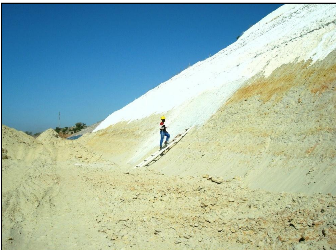
Aplicação concomitante com o avanço da terraplenagem.
