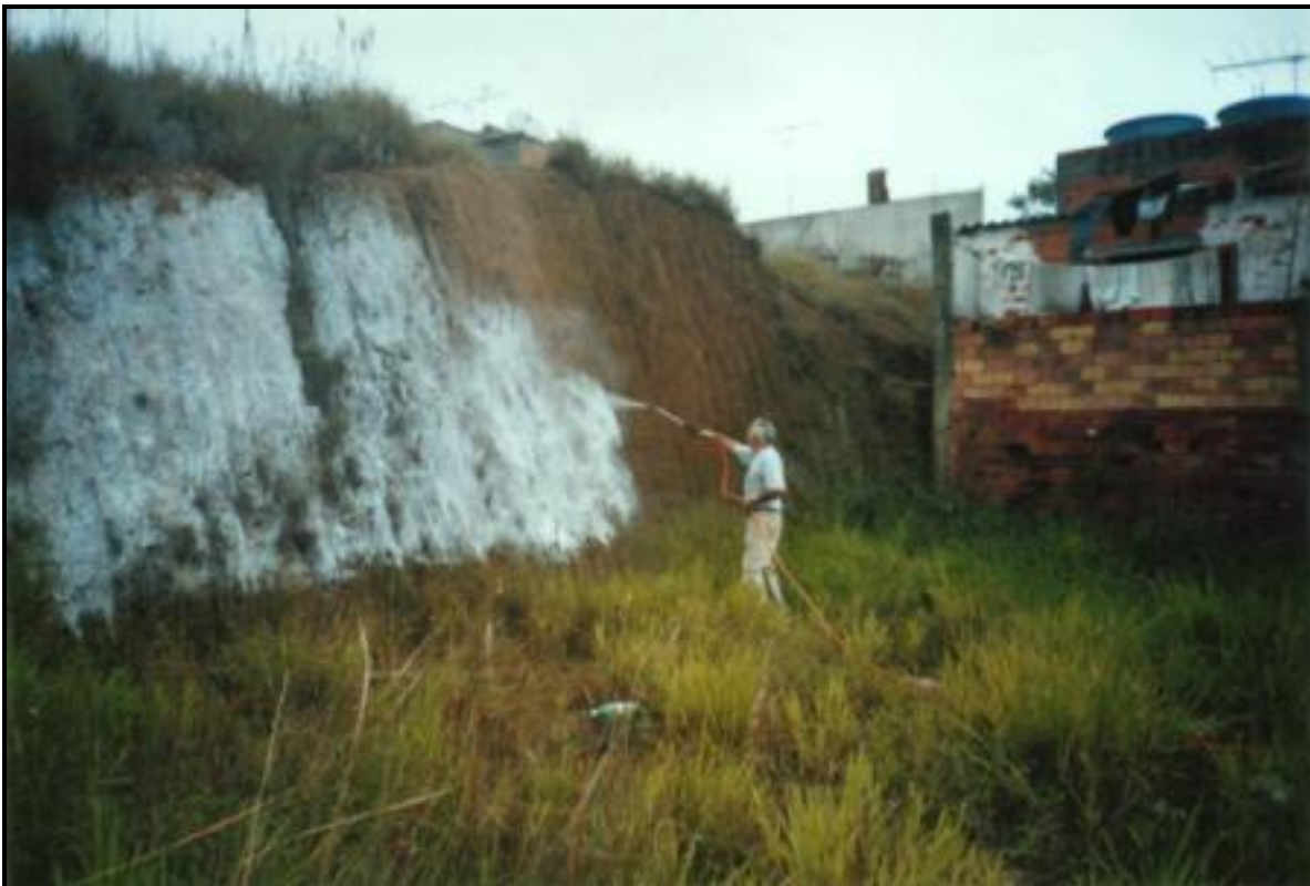
Mangueira de 30 metros possibilitando grande raio de ação
