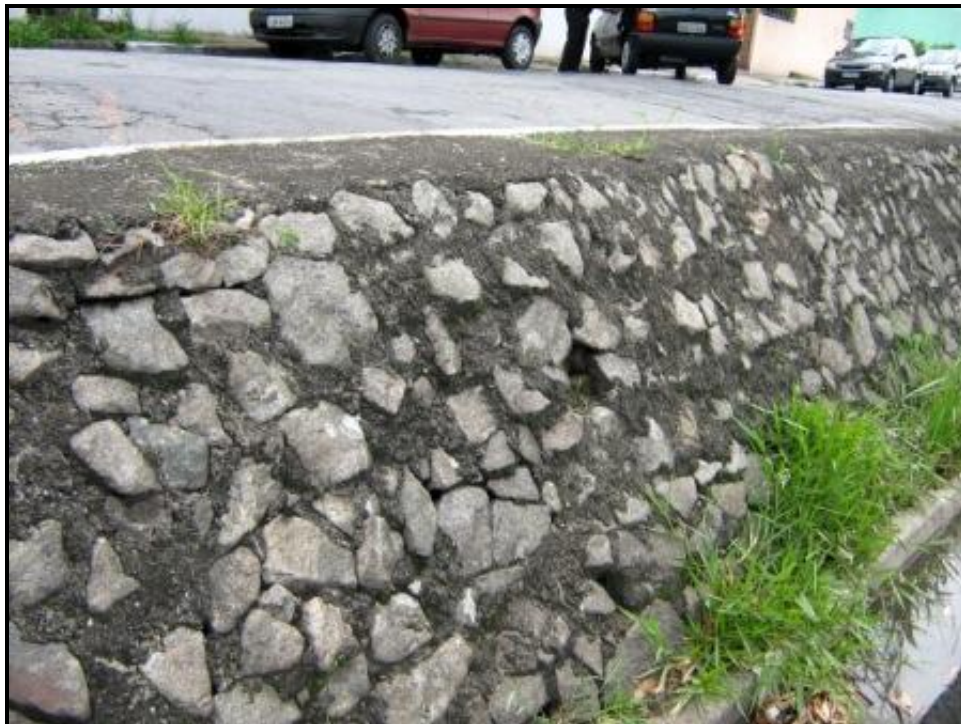
Um pano de pedra em proteção de taludes com acabamento de crista. (Foto do Autor)
