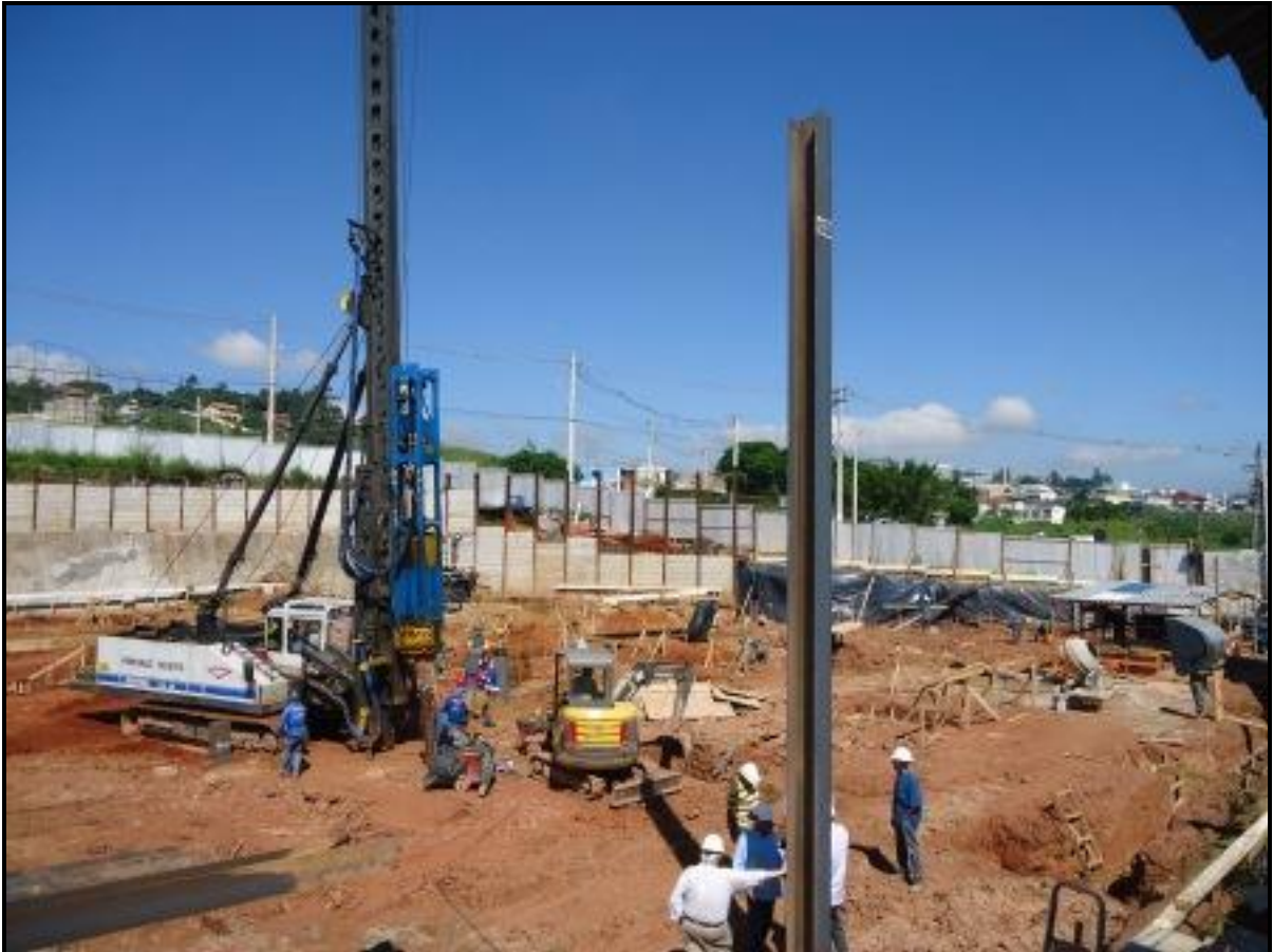
Empreendimento imobiliário ocupando gleba com concentração de vazios cársticos. As condições geológicas levaram à opção por estacas metálicas cravadas e tratamento dos vazios cársticos com injeção de calda de cimento. Foto ARSantos
