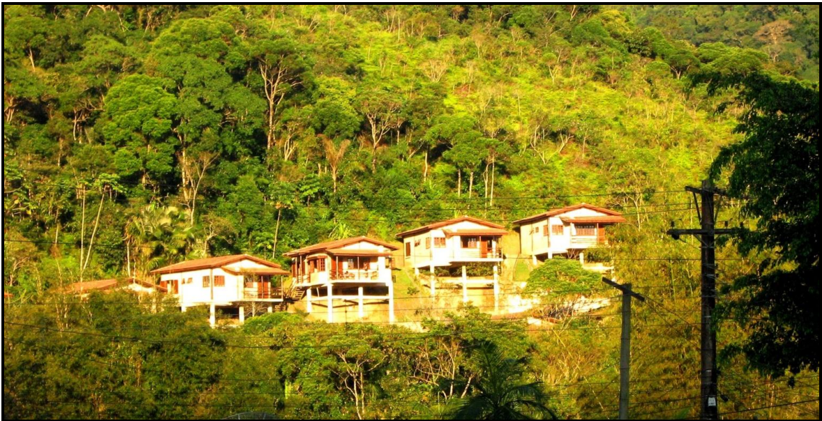
Casas construídas em encosta da Serra do Mar no conceito laje lançada sobre pilotis, ou seja, sem cortes no terreno. Foto do autor.
