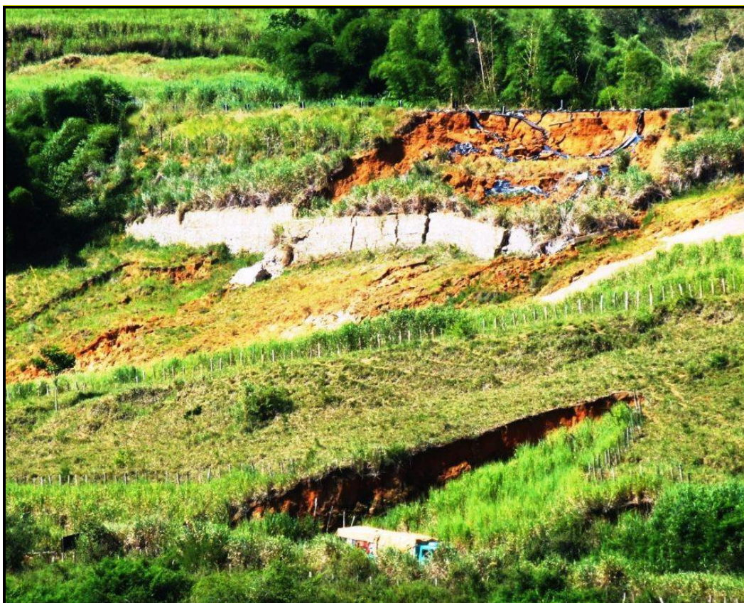
Escorregamento em rodovia na Serra do Marçal (BA). Muro de arrimo destruído por ter sido erroneamente construído sobre talude que poderia se movimentar. “Solução” que colaborou para o escorregamento que veio realmente a ocorrer. (Foto Nelson Custódio da Silveira Filho)
