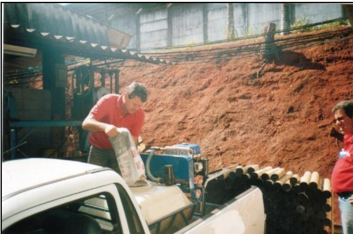
O tanque misturador/agitador sendo carregado com cal. O talude a ser protegido ao fundo
