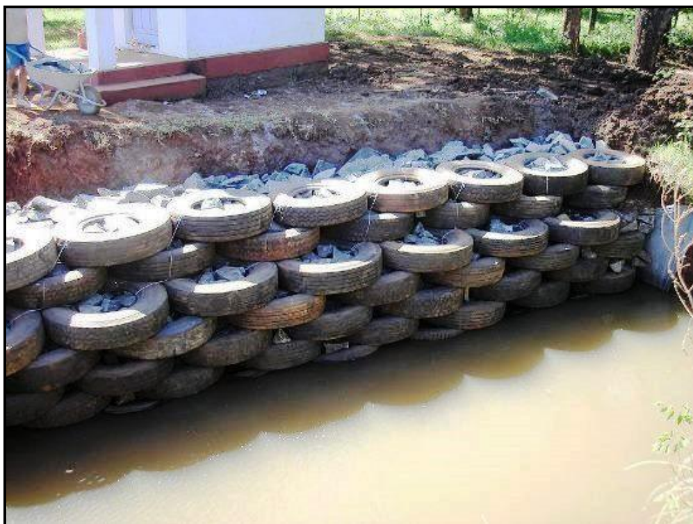
Muro de contenção e proteção de margem com pneus amarrados e preenchimento de rachão.
