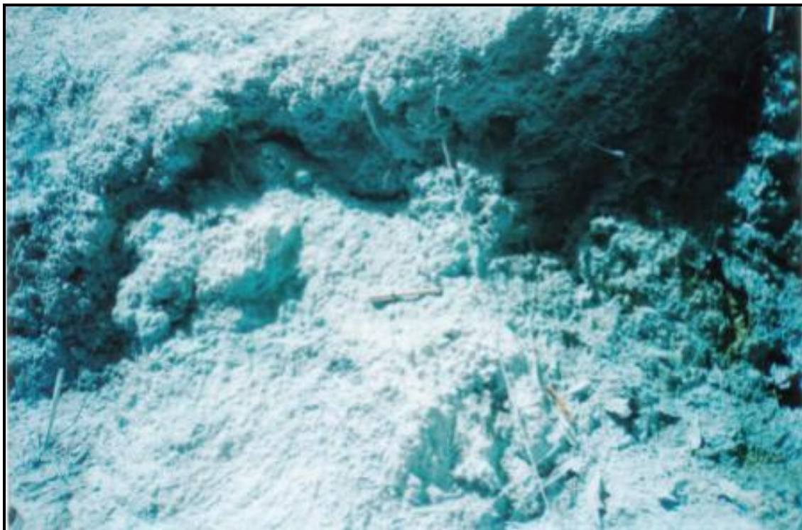
Detalhe mostrando reentrâncias do talude alcançadas e protegidas pela pulverização
