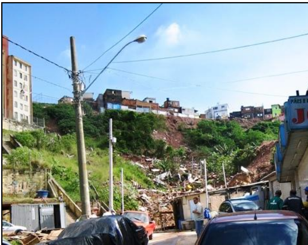
Grota urbanizada onde ocorreram deslizamentos que causaram várias vítimas fatais
