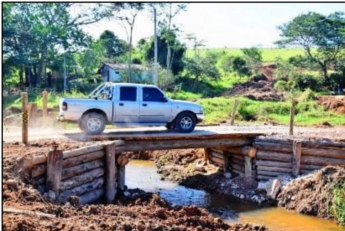
Pequena ponte com escoramentos de toras de eucalipto.
