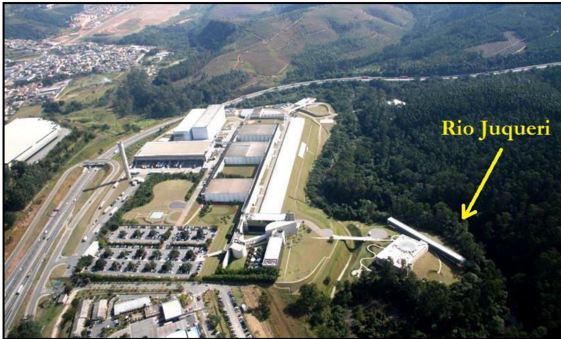
Moderna fábrica da Natura contígua à Via Anhanguera, bairro de Polvilho em Cajamar – SP, afetada por fenômenos cársticos. Notar a associação com o vale do rio Juqueri. Foto Natura.
