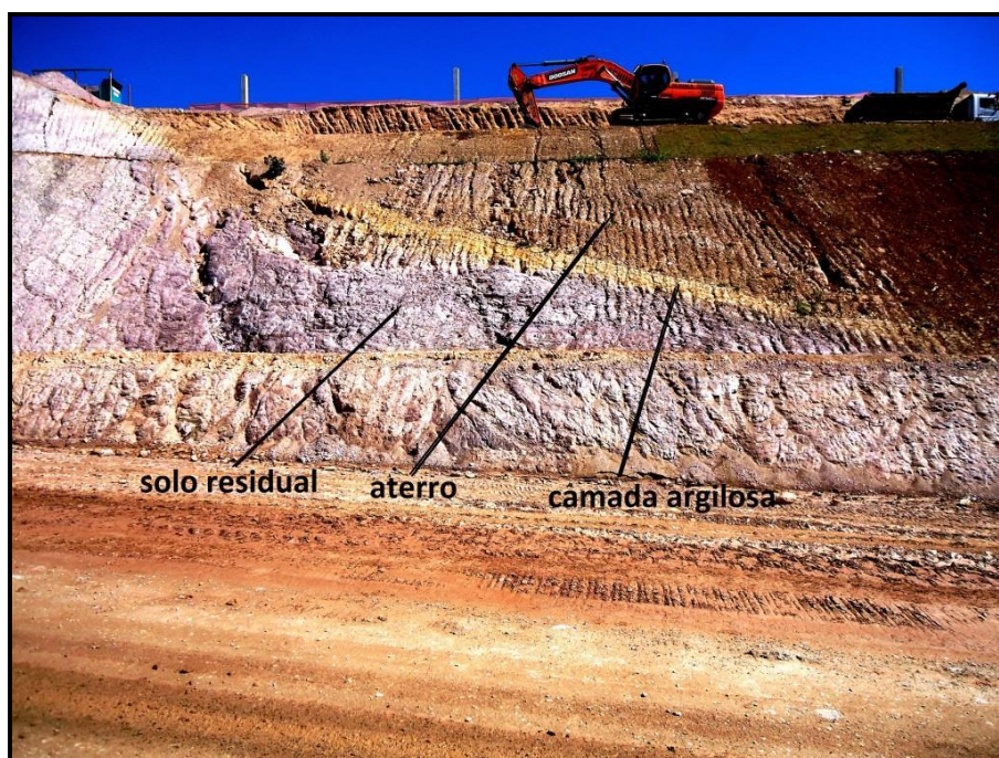
Corte em cabeceira de drenagem aterrada mostrando o aterro assentado sobre a camada superficial argilosa de baixa permeabilidade
