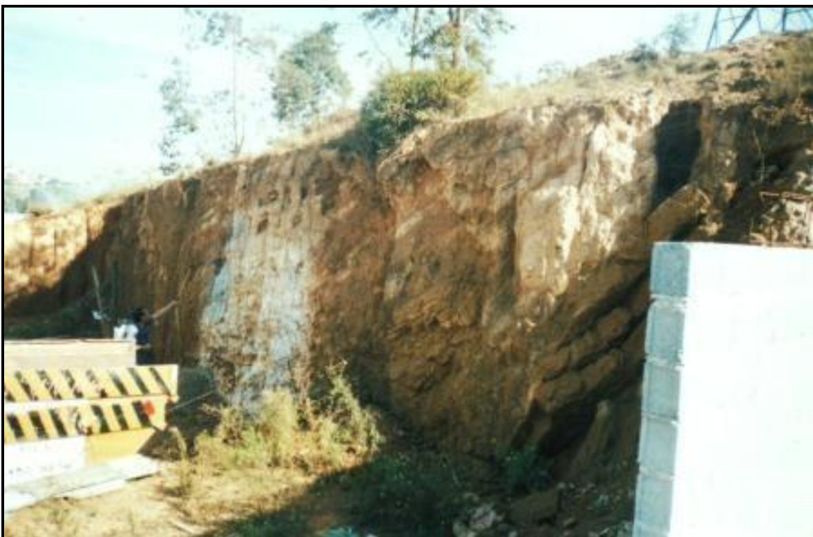
Talude antes da proteção
