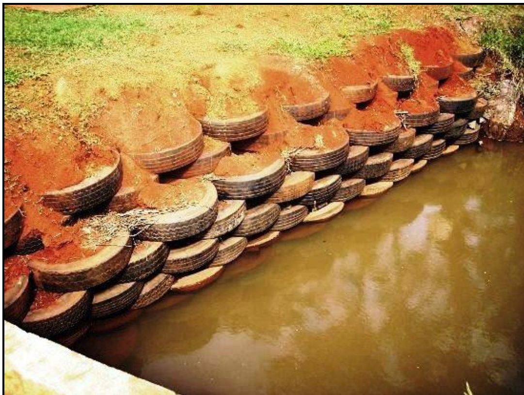
Muro de contenção e proteção de margem com pneus amarrados e preenchimento de solo
