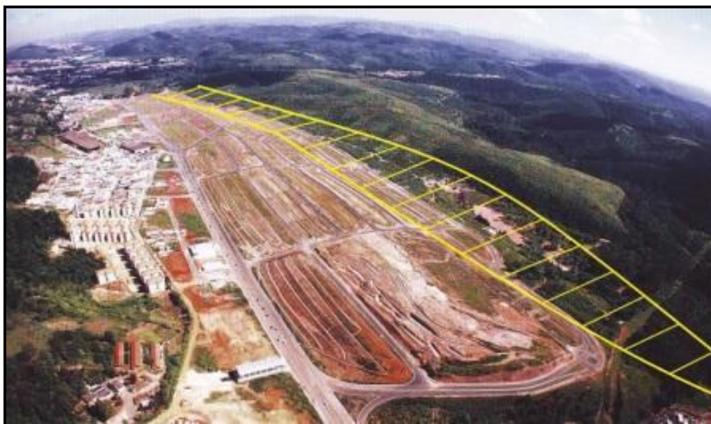
Extensa faixa de concentração de vazios cársticos expressa geomorfologicamente pela zona de fundo de vale (alinhamento 3 – Polvilho – Natura) ocupada por grande empreendimento imobiliário. Desenho ARSantos sobre imagem aérea.
