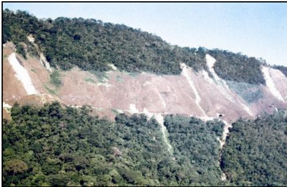
Erro idêntico cometido pela engenharia brasileira no trecho Serra do Mar da Estrada de Ferro Sorocabana. Notar os inúmeros deslizamentos associados a esse desmatamento.
