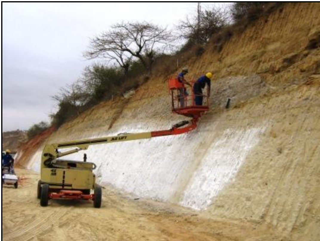
Expediente para aplicação em áreas mais altas do talude
