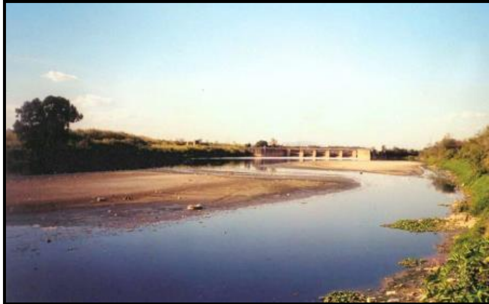
A cultura urbana da erosão e do assoreamento
