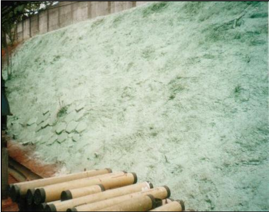
Proteção concluída com 2ª demão pigmentada
