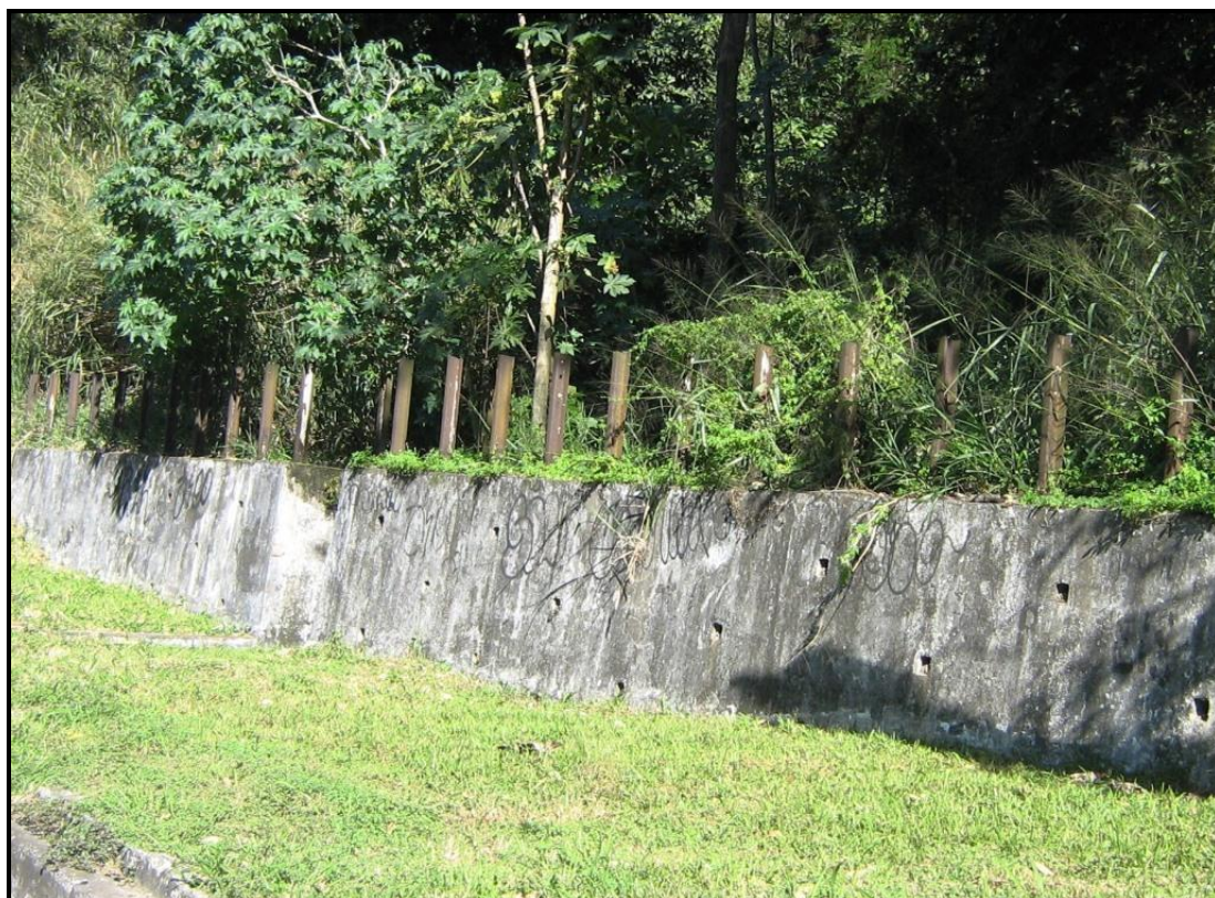
Muro de pedras rejuntadas reforçado com pedaços de trilhos. Dentro de uma estratégia técnica de aproveitamento máximo de materiais disponíveis no local.
