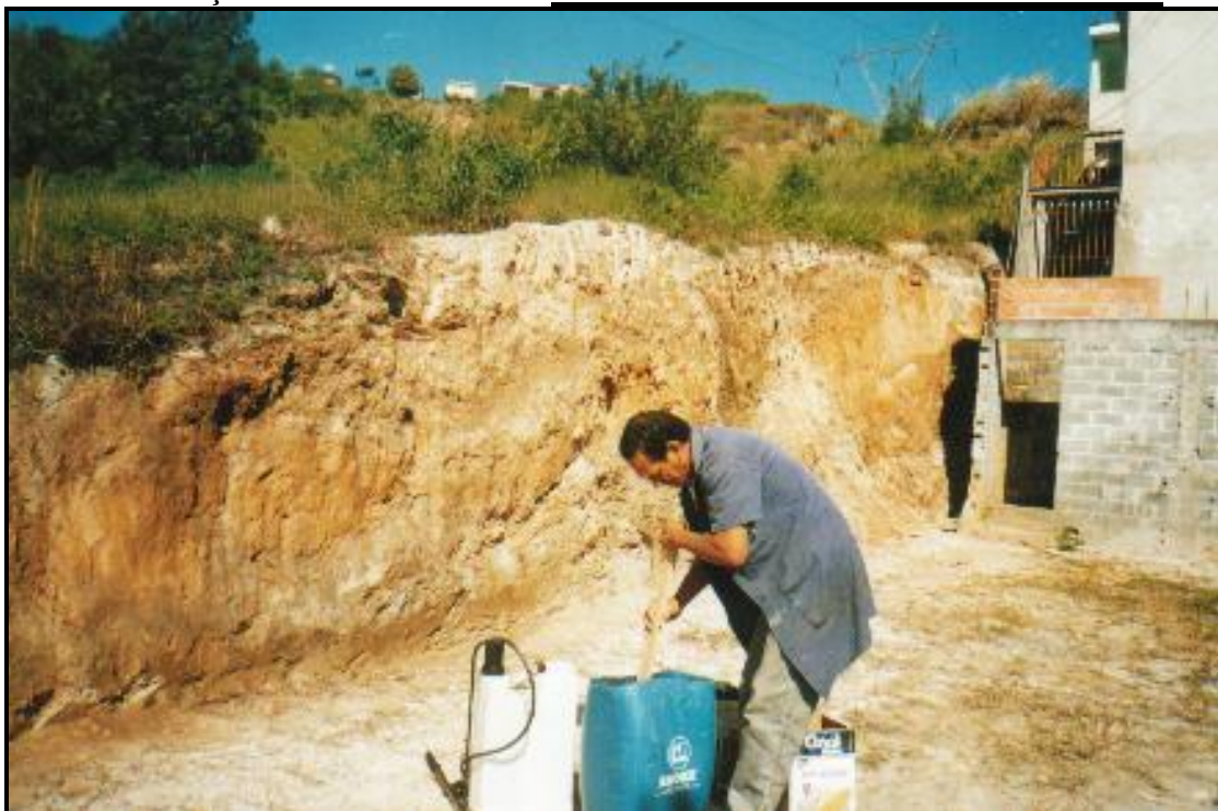
Preparando a calda
