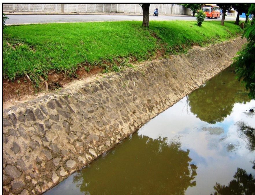
Pano de pedra na proteção de margens de cursos d'água. (Foto do Autor)
