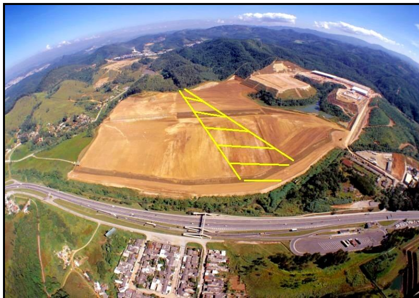
Empreendimento imobiliário em que a prospecção geológica detectou faixa de concentração de vazios cársticos (linhas amarelas), coincidente com o alinhamento cárstico Lavrinhas. Foto ARSantos
