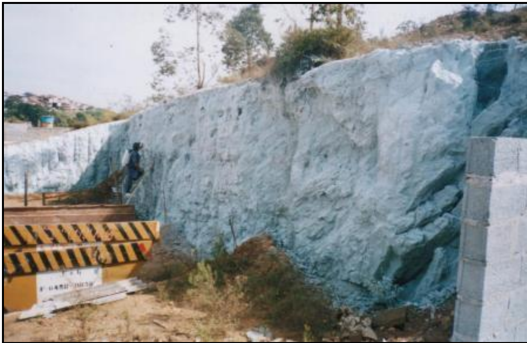
O mesmo talude após a proteção concluída
