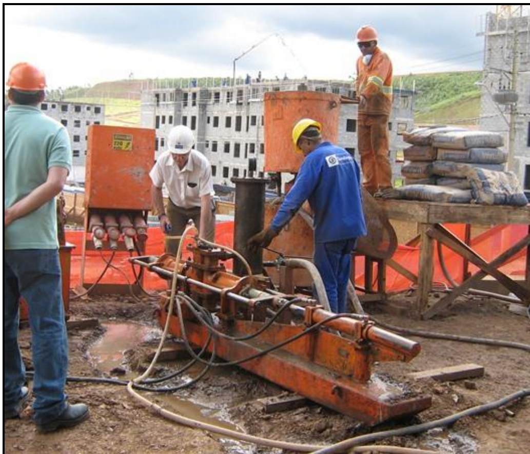
Bomba pneumática utilizada para a injeção de calda de cimento com misturador acoplado. Foto ARSantos.
