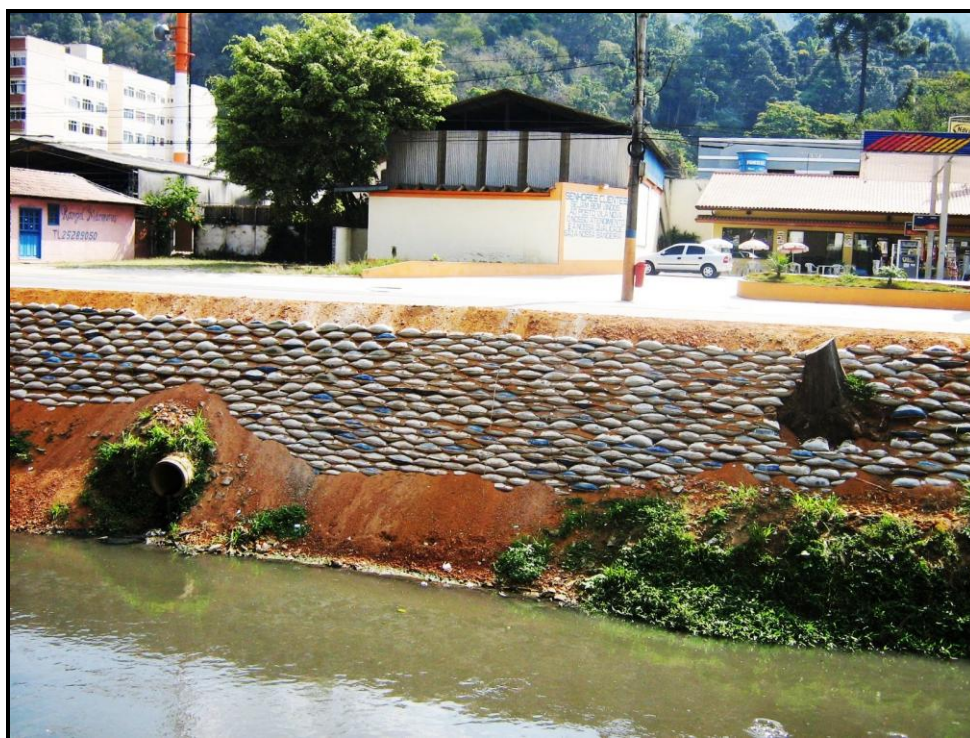
Proteção de margens com sacos de solo-cal. (Foto do Autor)
