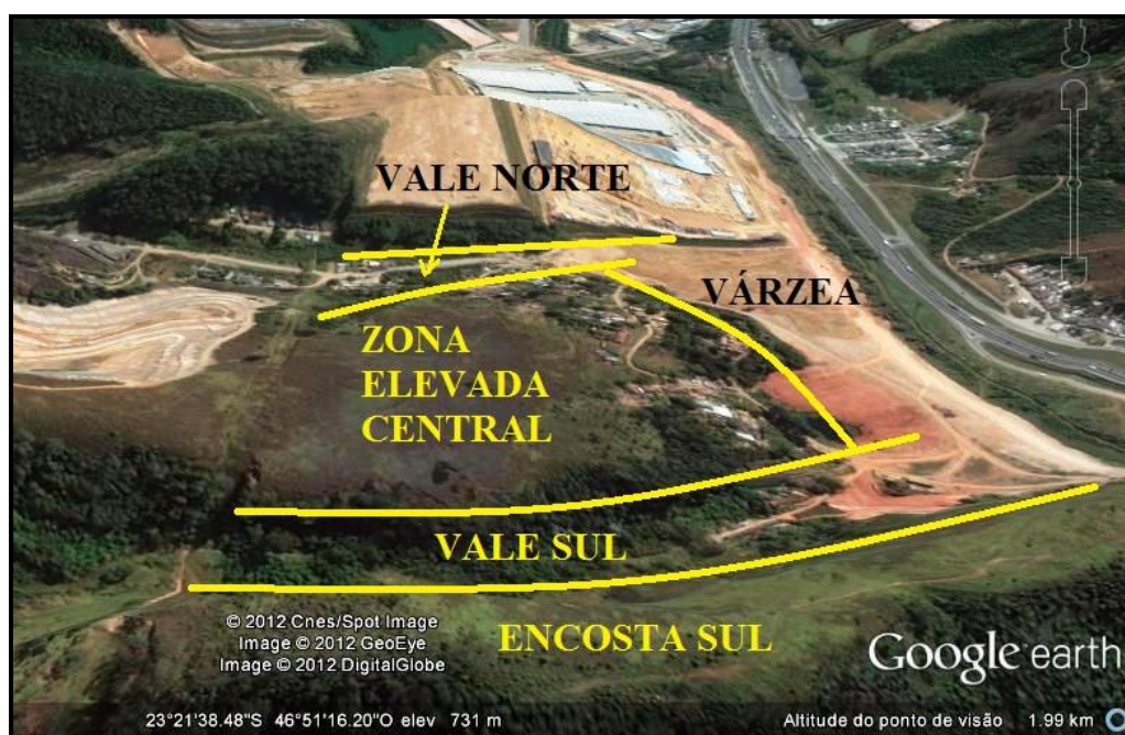
Gleba a ser ocupada por futuro grande empreendimento logístico cuja setorização geomorfológica inicial orientou as investigações e confirmou a maior concentração de vazios cársticos nas zonas baixas do Vale Norte, do Vale Sul e da Várzea.
