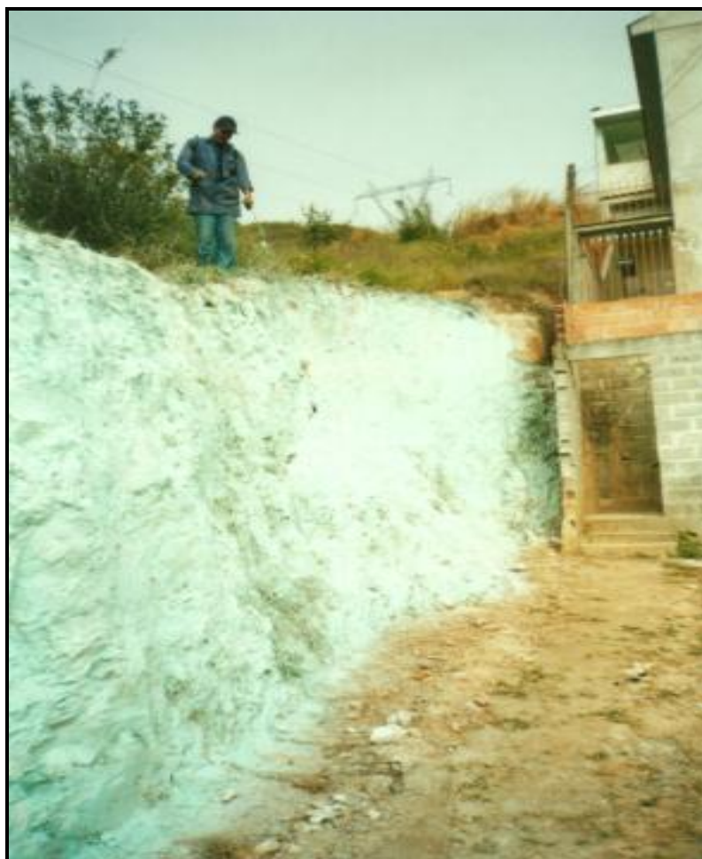
Proteção concluída com a 2ª demão pigmentada e retoques pela crista do talude
