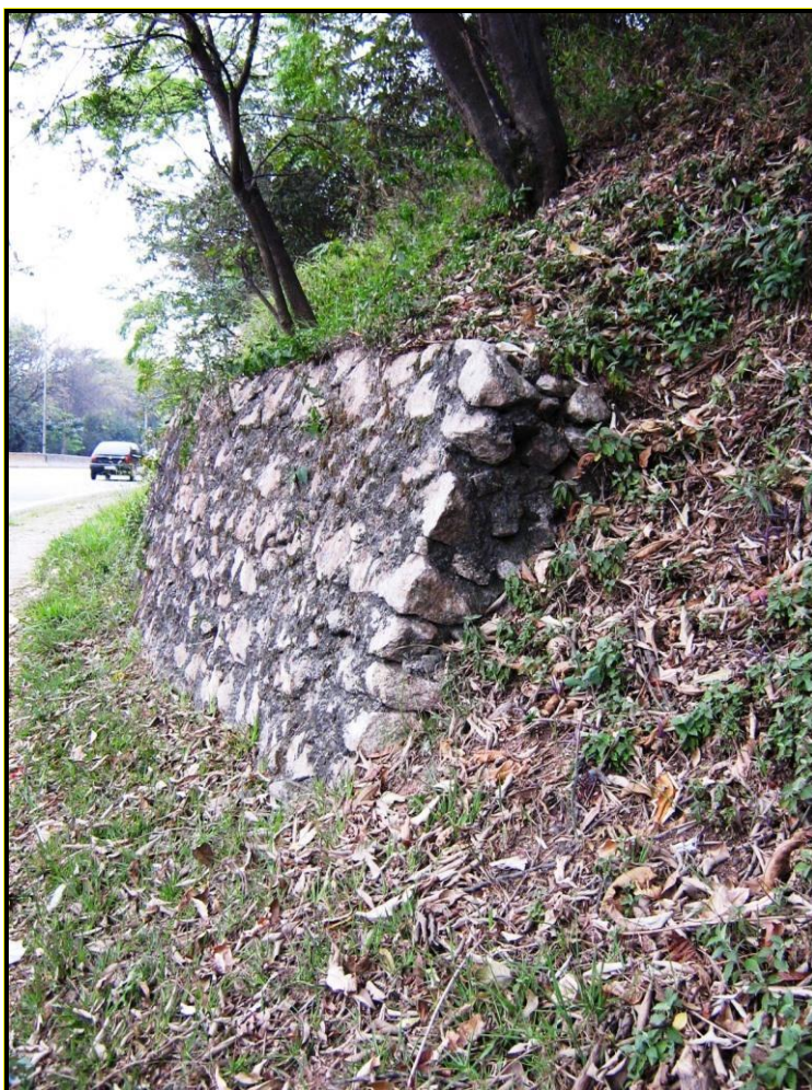
Um pequeno muro de arrimo de pedras rejuntadas. (Foto do Autor)
